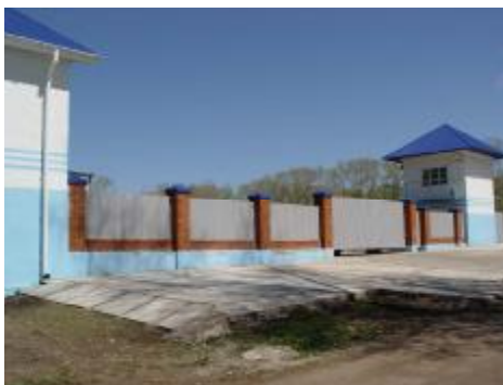
Въезд на территорию базы - вид со стороны улицы
